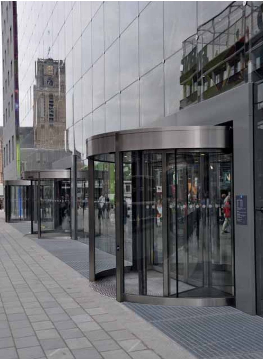
De kopgevel van de markthal met de tourniquets en in het midden de schuifdeur. In de straat zijn de roosters te zien die samen met de deuren de toevoer garanderen.
